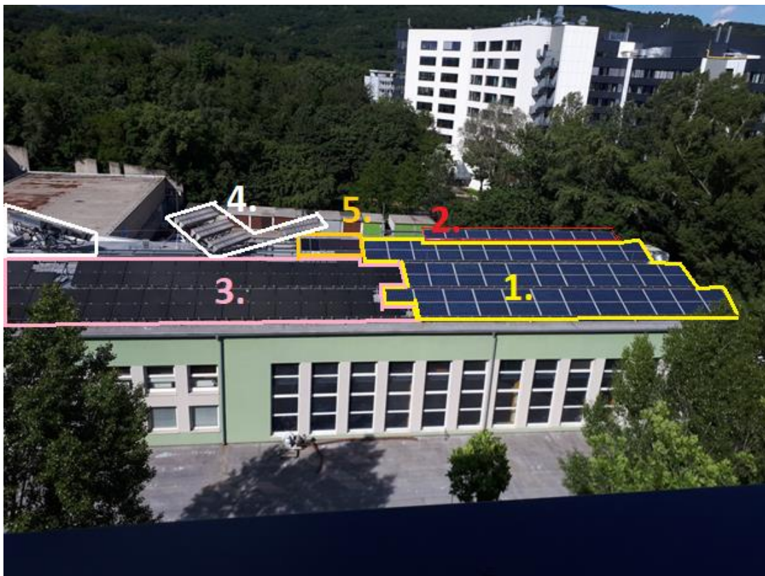
Obrázok 11 Situácia strešnej FVE UMMS SAV a jej jednotlivých častí
