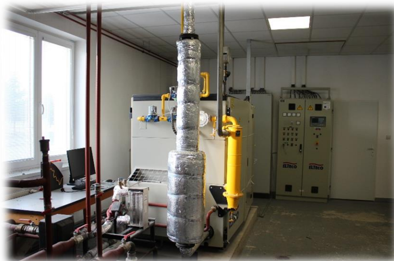
Obrázok 8 Kogeneračná jednotka
