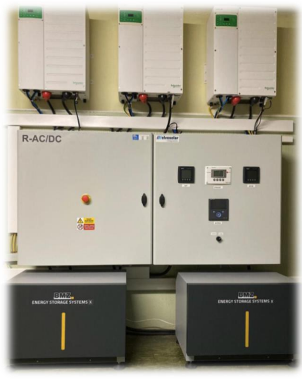
Obrázok 5 Batériový akumulčný systém
