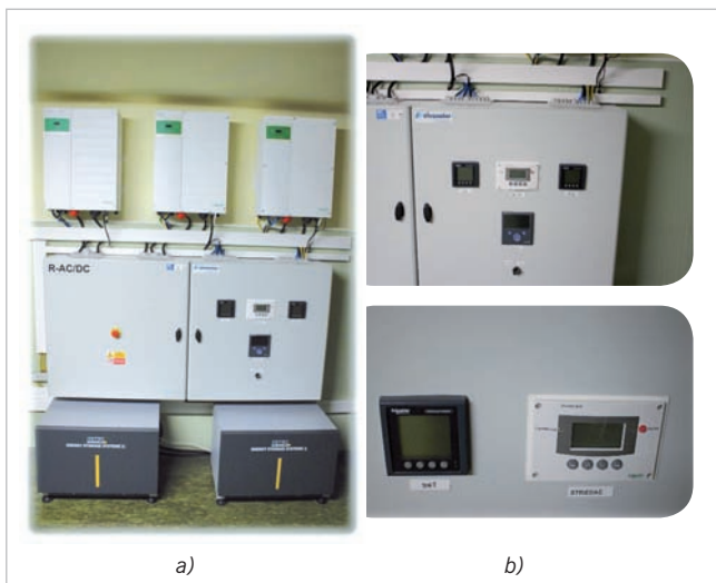
Obr. 1 a) Jeden z meracích bodov je situovaný vo vybudovanom batériovom úložisku. b) Detailný záber na meraciu zostavu.
