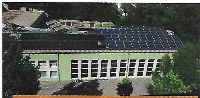
Obr. 4, Fotovoltaická elektráreň umiestnená v Ústave materiálov a mechaniky strojov, (polyplyšatické - modré a CIS - tmavé FV panely)
