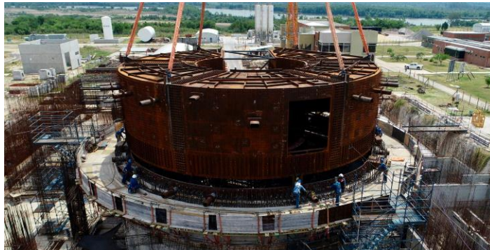
Obr.1 Výstavba reaktora CAREM [10].
