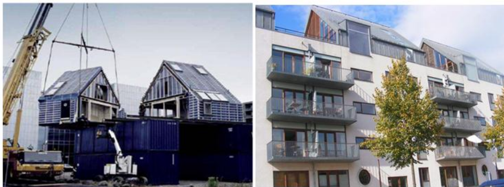
Obr.1 Modulárny dizajn, založený na priemyselne predpripravených prvkoch, ktorý je možné kombinovať aj s konvenčným dizajnom.
