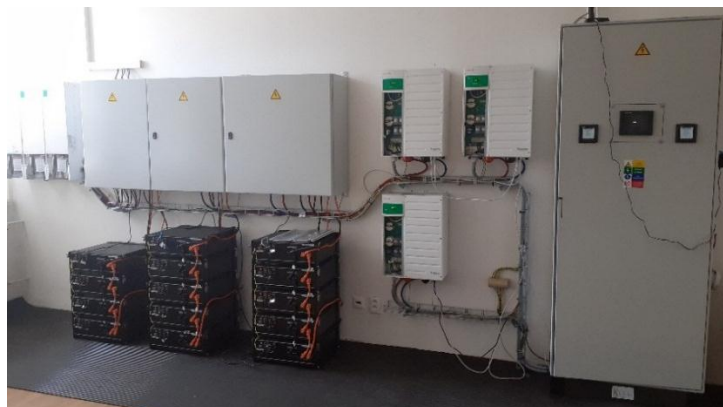
Obr.3 Nové rozšírenie Smartgridu o batériové úložisko so systémom nabíjačiek a striedačov.
